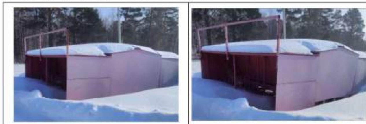
Понка для животных "Горячий ключ" ГК-КРС-4, инв. №№ БП-001001, БП-001002, БП-001003, БП-001004, БП-001106, БП-001107, БП-001448, БП-001449, БП-001450, БП-001451
