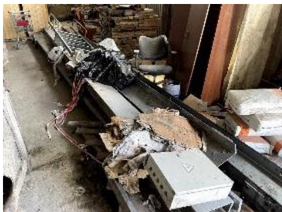
Фото 13 Опорная металлоконструкция для крепления приводов
