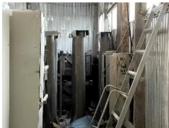
Фото 12 Опорная металлоконструкция (SABP- 043.493)
