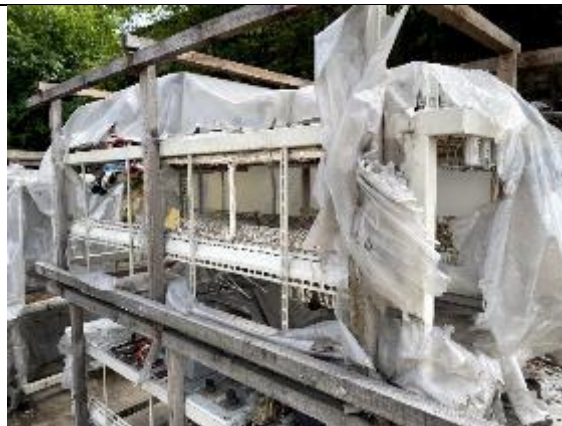
Фото 18 Панель №48 устройства АЧР Т5, Т6 (2)
