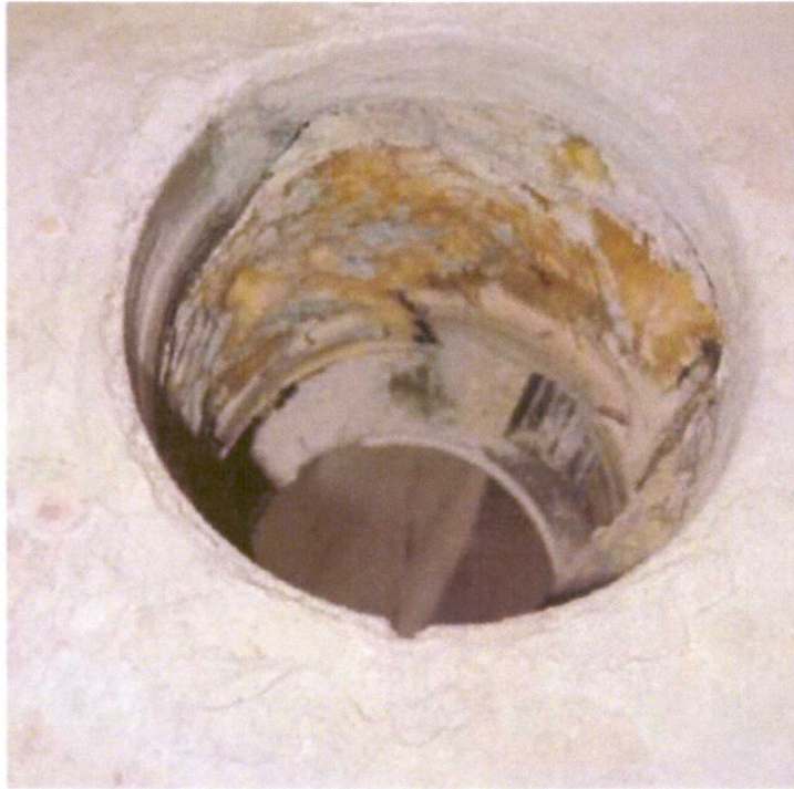
Конструкция перекрытия 3 этажа на участке контрольного вскрытия
