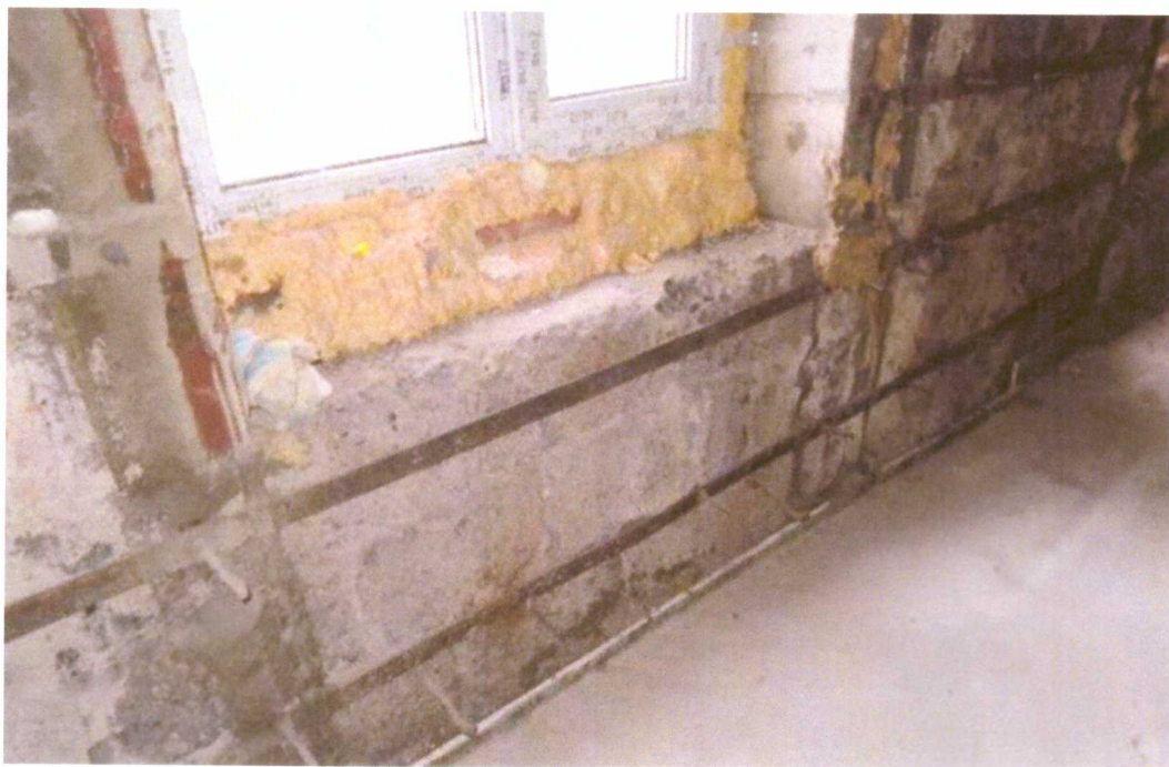
Конструкция усиления деформированной стены 1 этажа
