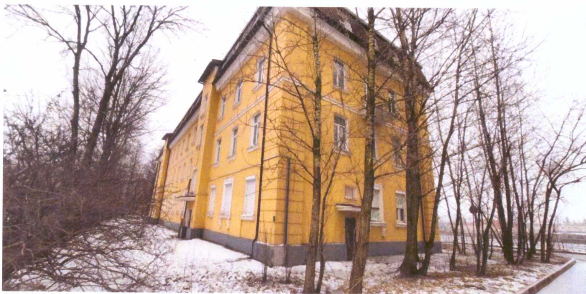
Общий вид здания. Торцевой и дворовый фасады здания
