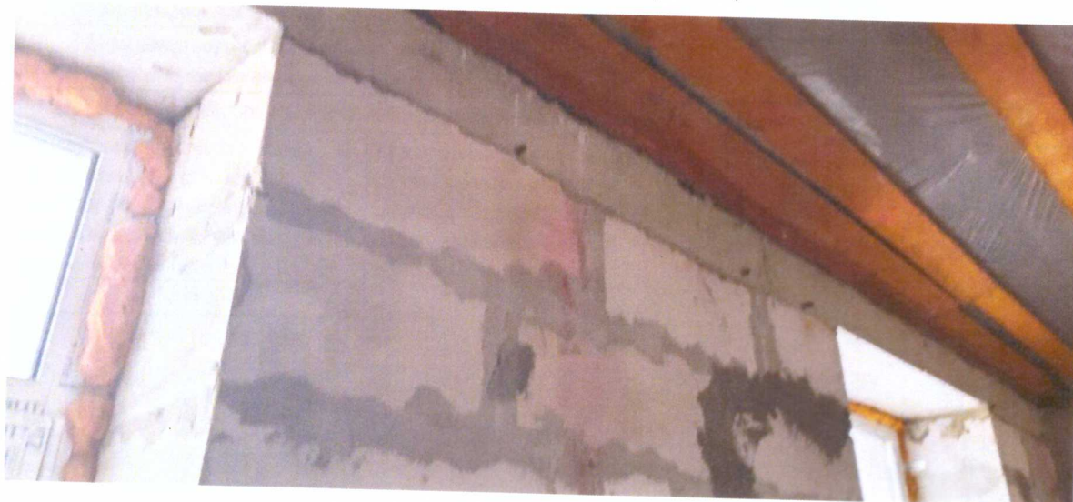
Монолитный пояс по верхнему обрезу кладки стены
