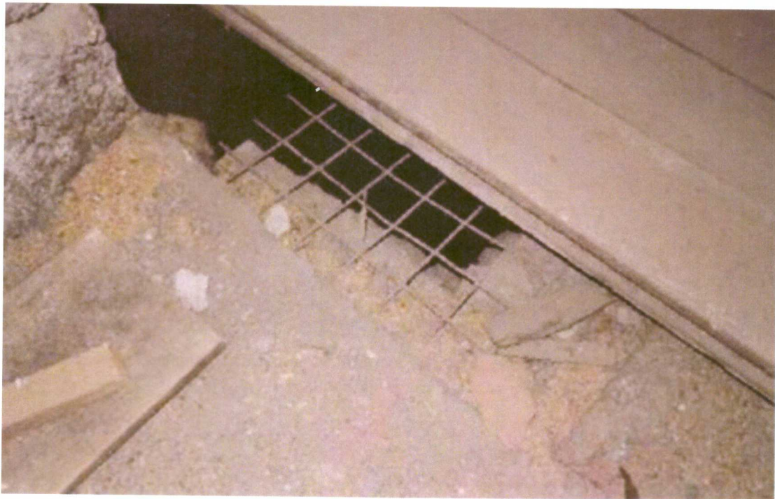
Перекрытие 2 этажа. Армирование бетонного пола в помещении 3 этажа
