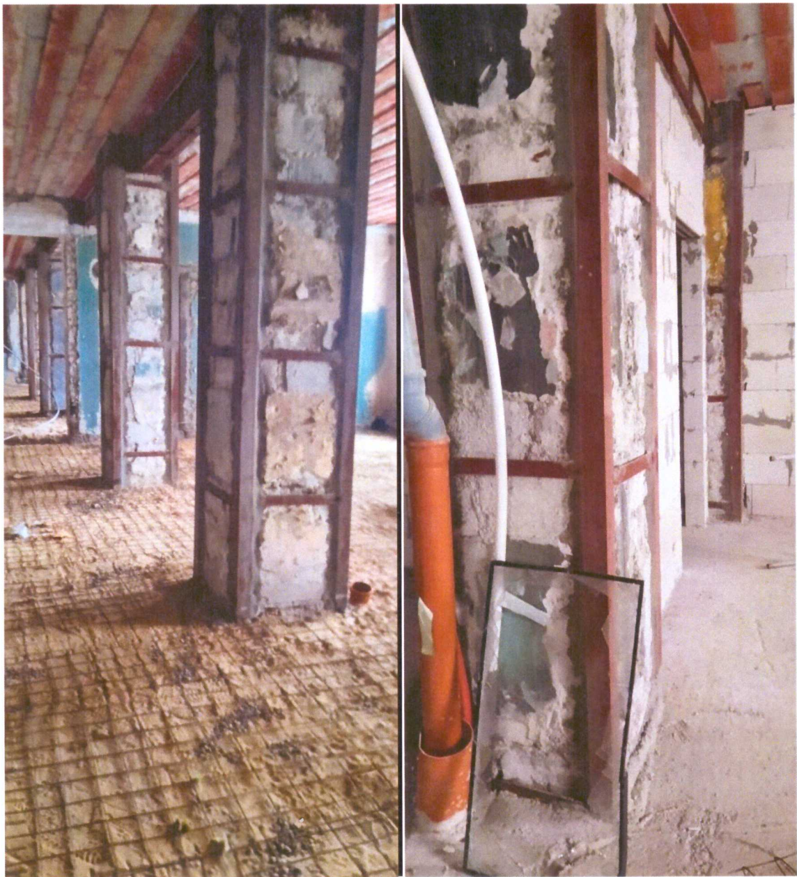
Конструкции усиления колонн
