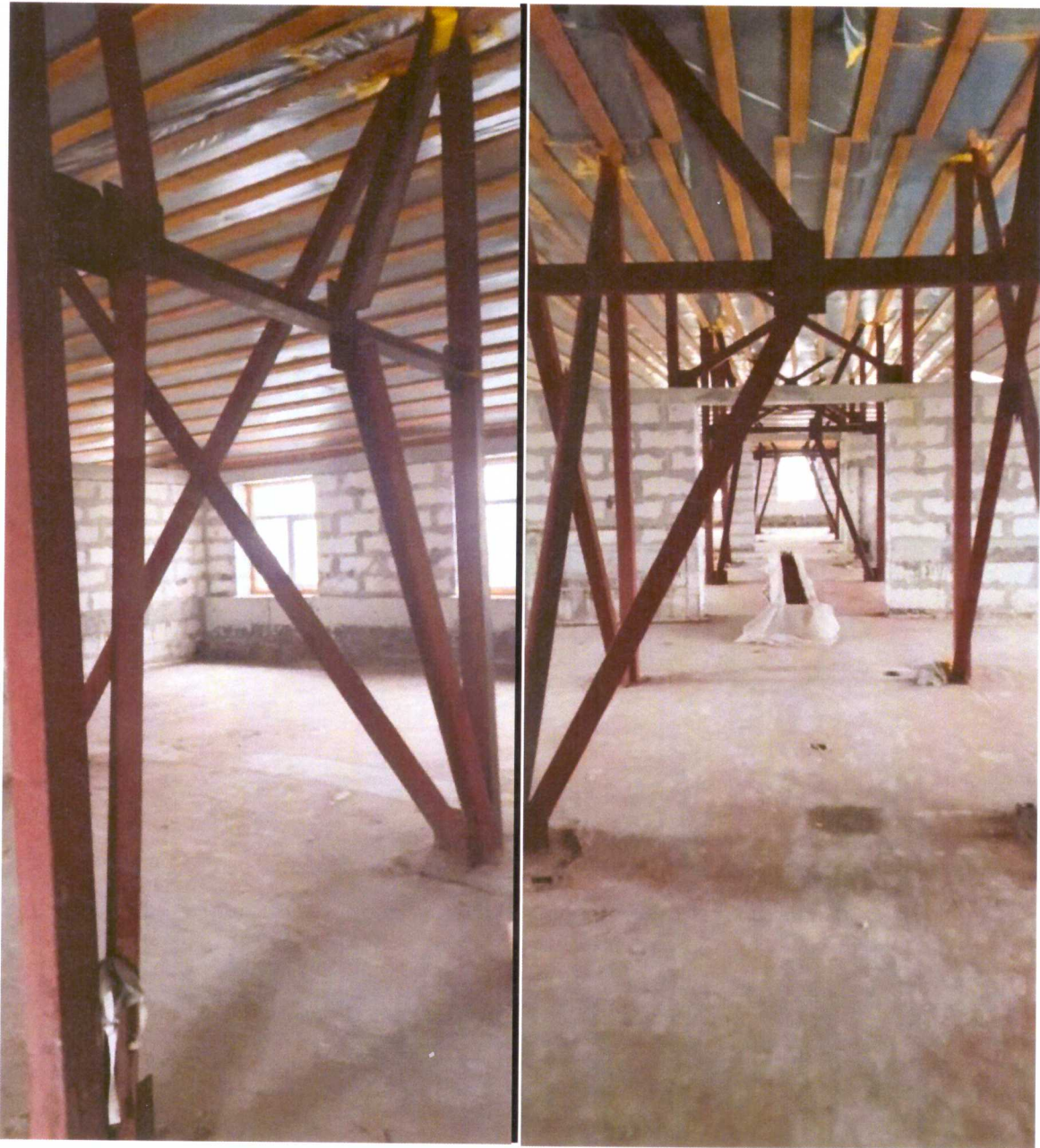
Металлоконструкции подкровельного каркаса
