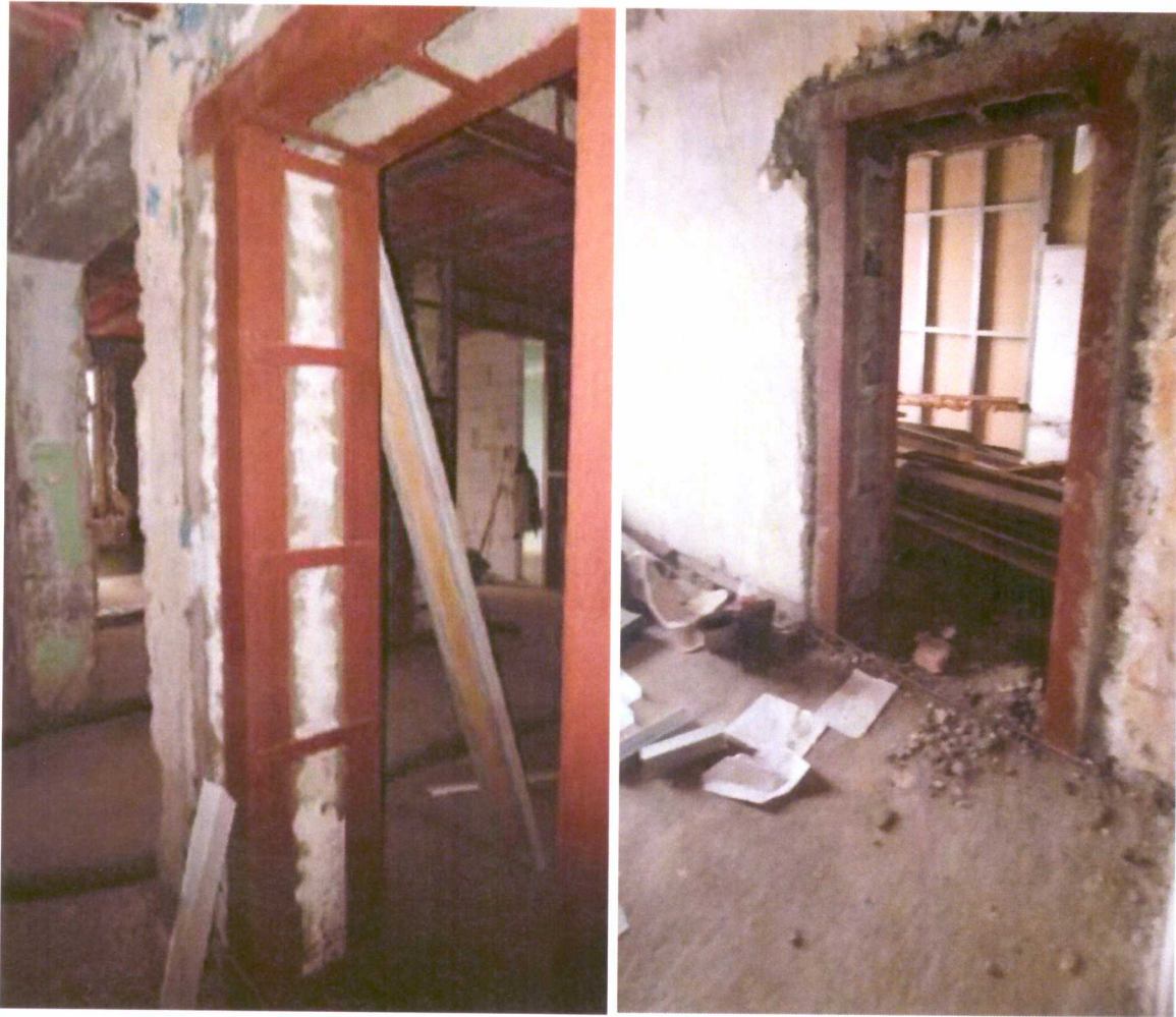
Металлоконструкции рам усиления стен на участках устройства дверных проёмов
