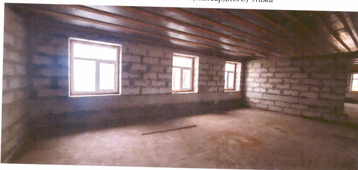
Общий вид помещений 4 (мансардного) этажа
