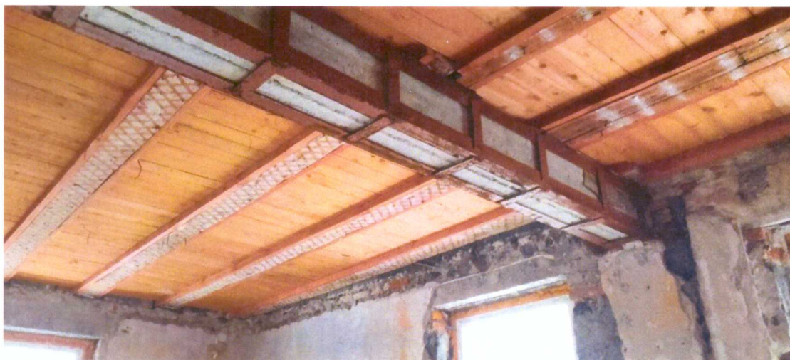
Первый этаж. Конструкции усиления ригелей. Конструкция перекрытия 1 этажа
