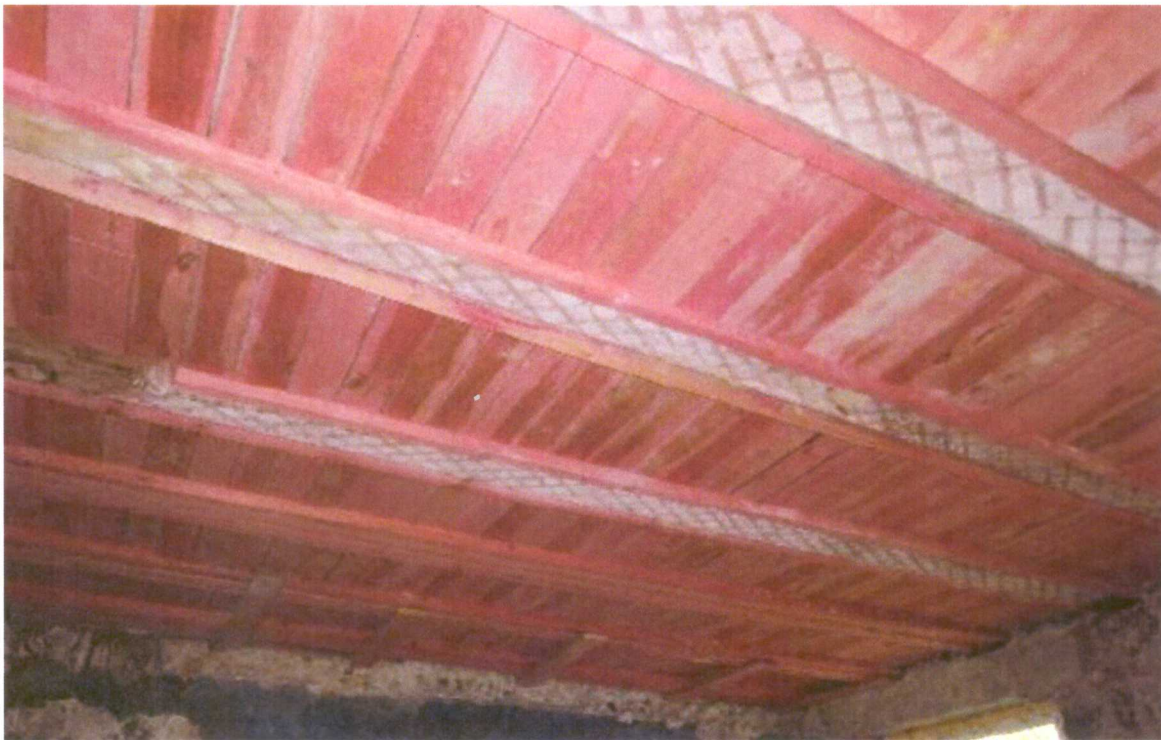
Перекрытие 2 этажа. Сплошная подшивка из досок сечением 25x125 мм по низу деревянных балок
