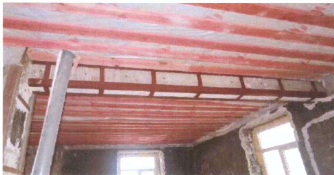
Первый этаж. Конструкции усиления ригелей. Конструкция перекрытия 1 этажа
