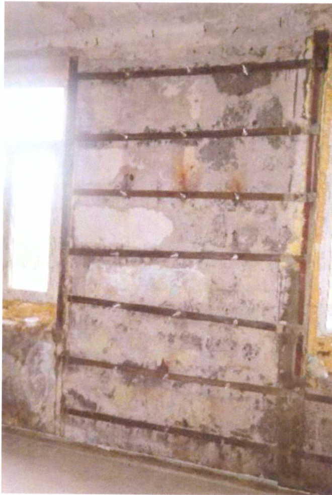
Конструкция усиления деформированной стены 1 этажа
