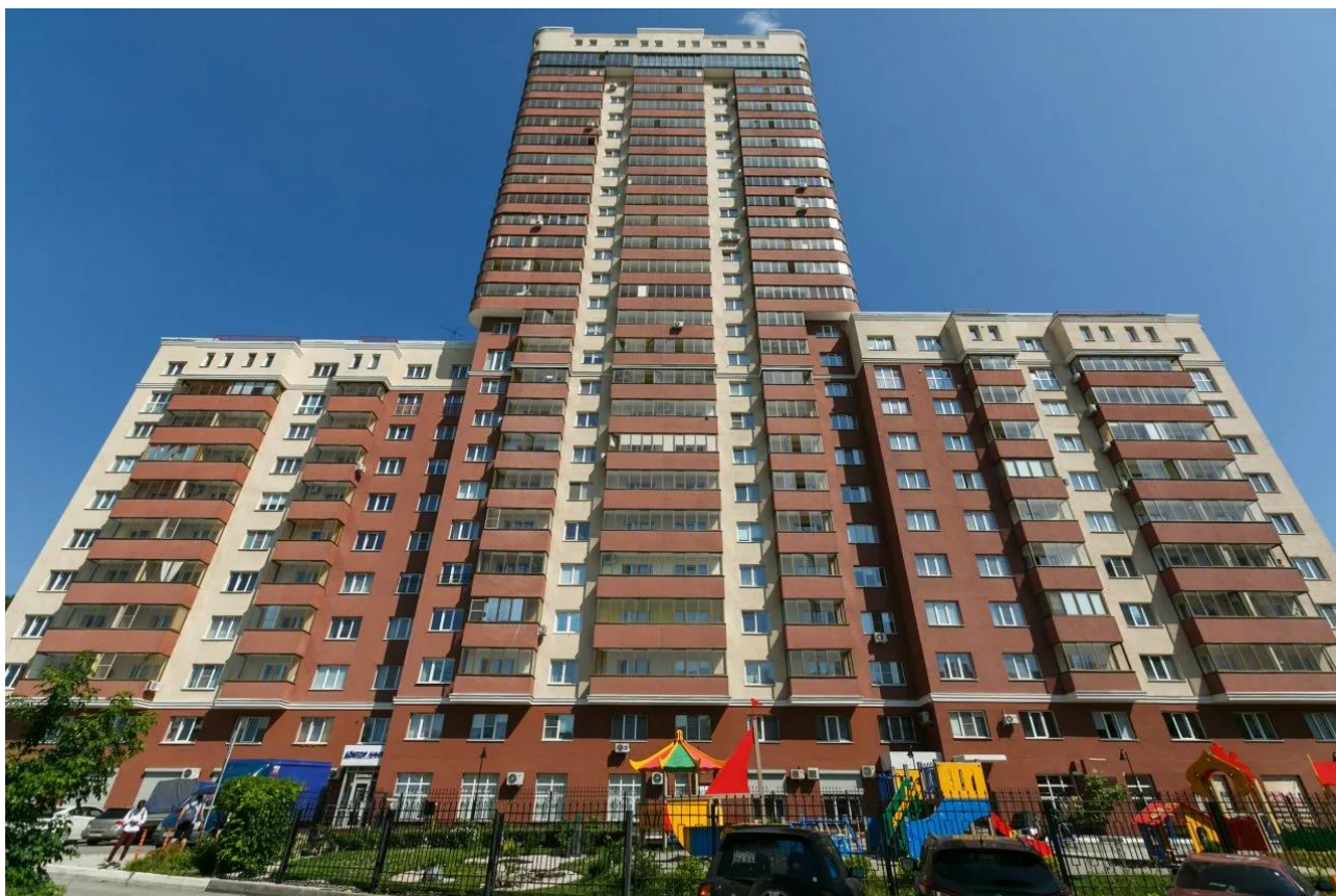
- Вид на здание где находятся машиноместа
