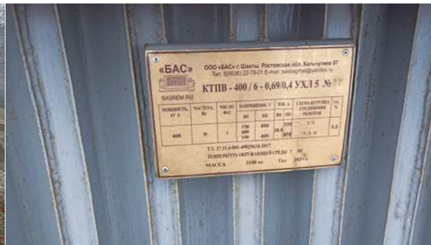
Трансформаторная подстанция КТПВ-400/6/0,69-0,4 УХЛ5
