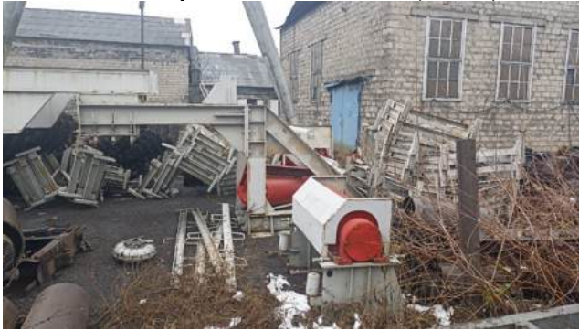
Конвейер ленточный ЛК-800 (L300м)
