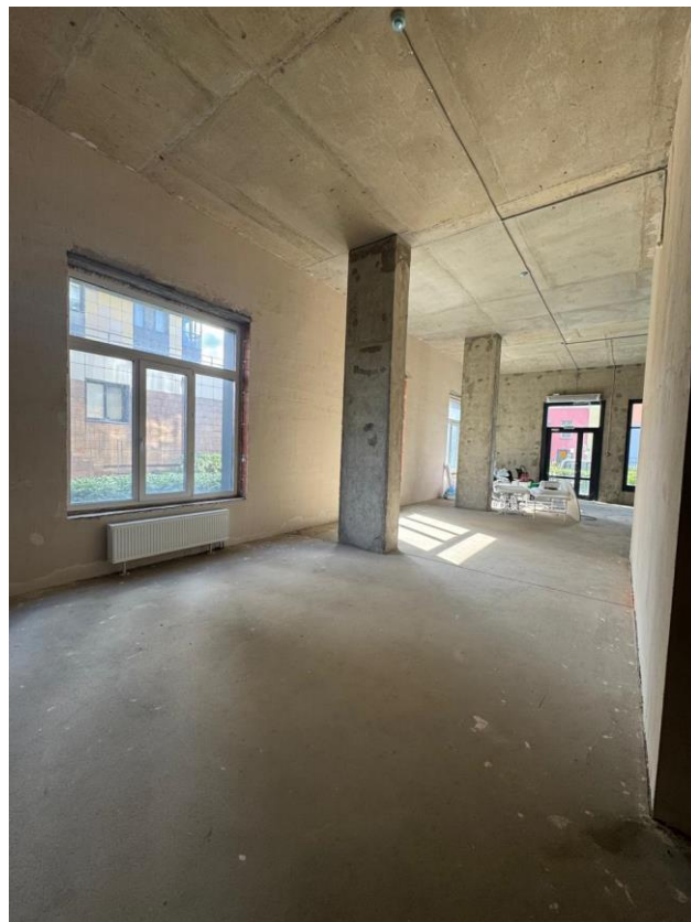
Фото 5. Помещения объекта оценки
