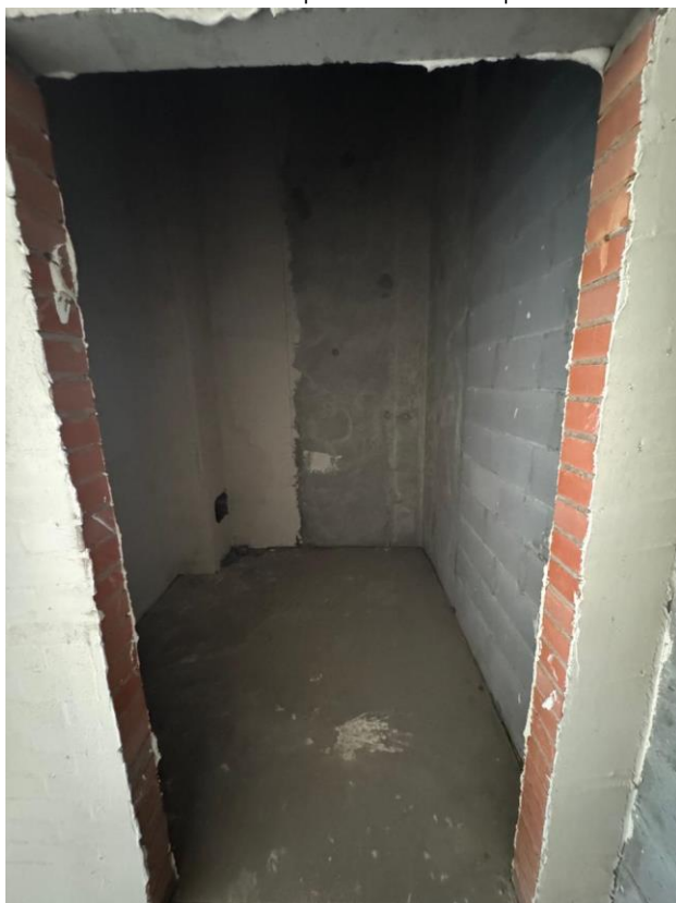
Фото 6. Помещения объекта оценки
