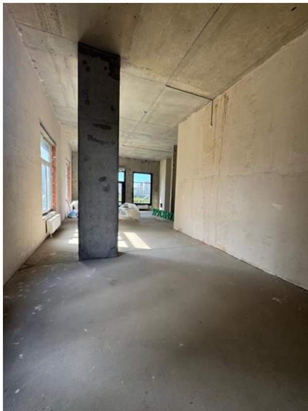
Фото 4. Помещения объекта оценки
