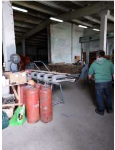
Фото 74. Состояние внутренних помещений
