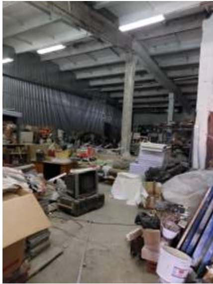
Фото 73. Состояние внутренних помещений
