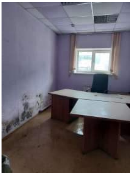
Фото 61. Состояние внутренних помещений
