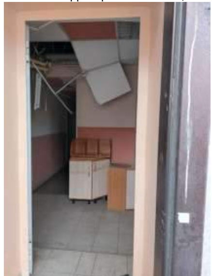
Фото 60. Состояние внутренних помещений
