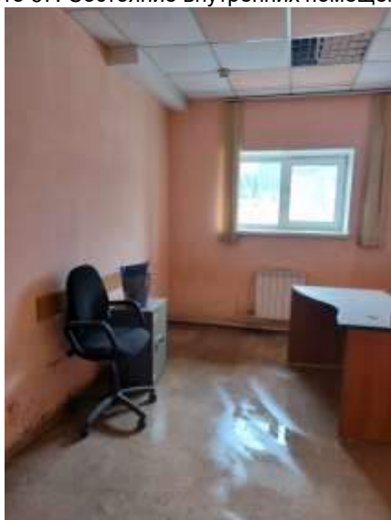
Фото 69. Состояние внутренних помещений
