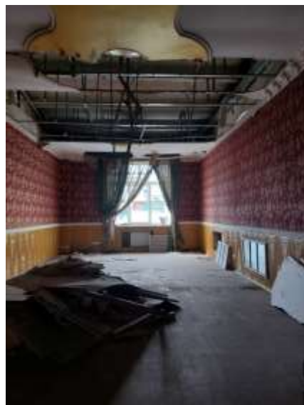
Фото 62. Состояние внутренних помещений
