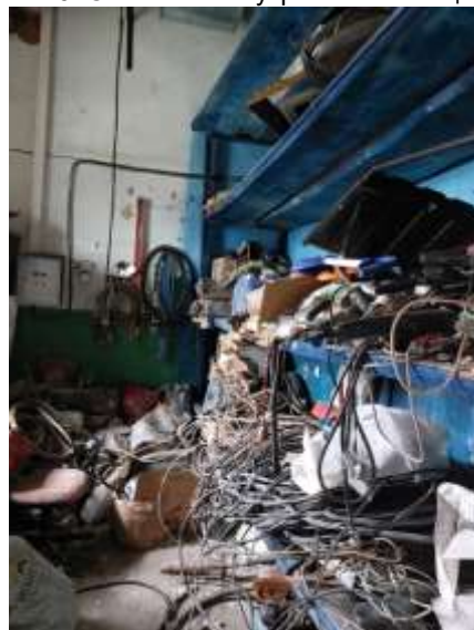
Фото 72. Состояние внутренних помещений
