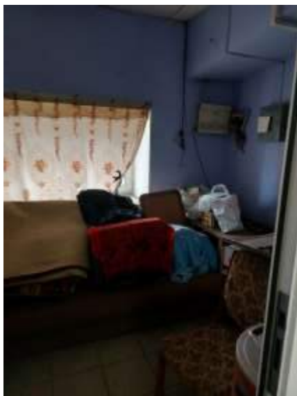
Фото 67. Состояние внутренних помещений
