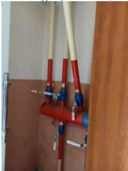
Фото 57. Состояние внутренних помещений
