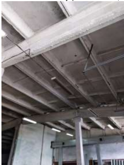
Фото 75. Состояние внутренних помещений
