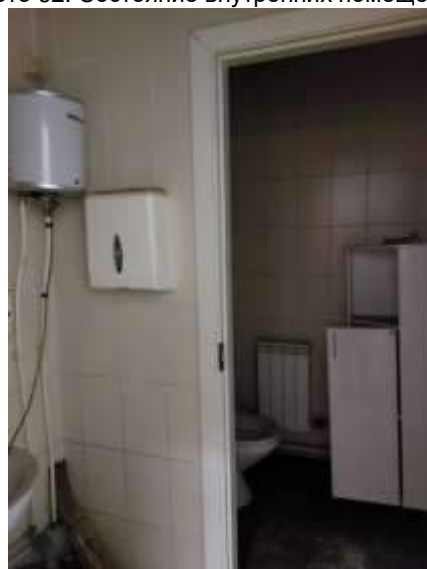
Фото 64. Состояние внутренних помещений
