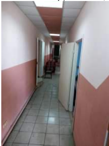
Фото 59. Состояние внутренних помещений
