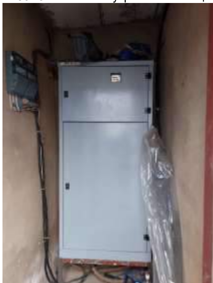
Фото 71. Состояние внутренних помещений
