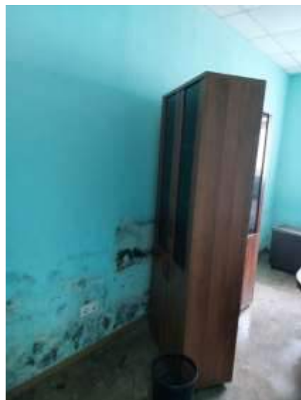
Фото 68. Состояние внутренних помещений
