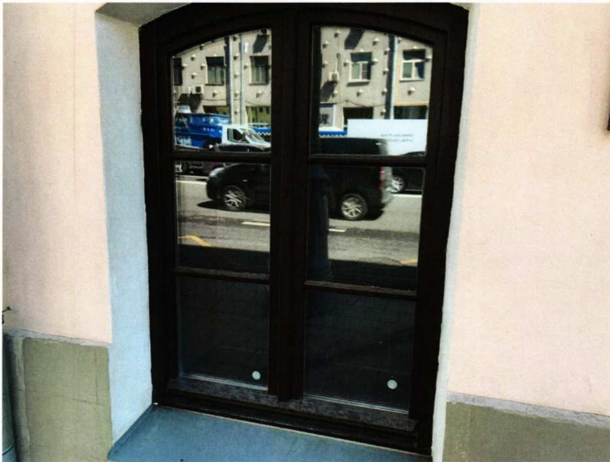
Фото 11. Фрагмент оконного заполнения.
