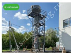
Скруббер с подвижной насадкой (с кипящим слоем)
