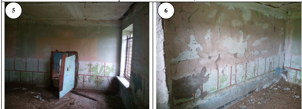
Состояние объекта оценки
